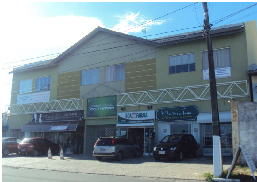
Edifício comercial em quadra restritamente residencial.
