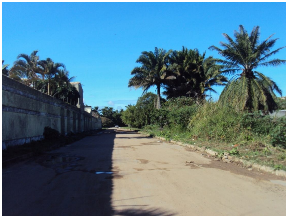
Via com condições precárias de infraestrutura.
